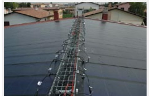
Realizzazione di impianto fotovoltaico per abitazione civile
